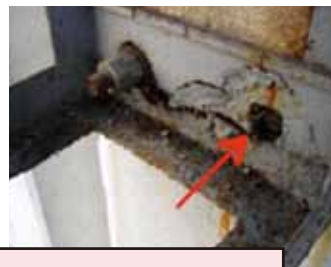
所定の場所にアンカーボルトがない状態
