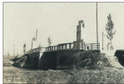
昭和12年ごろの平和橋(提供:名古屋都市センター)
