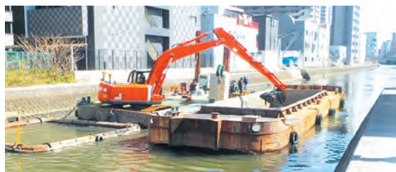
堀川で川底を掘る工事の様子
