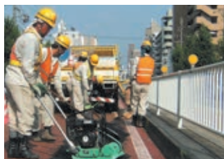
道路の舗装修繕
