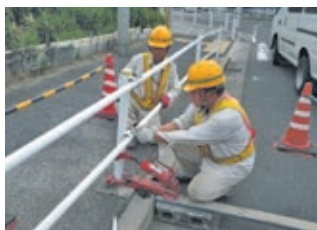
防護柵の補修
