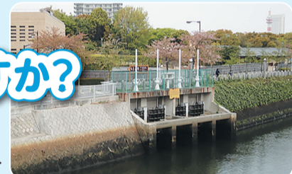
白鳥橋ポンプ所放流口▶
