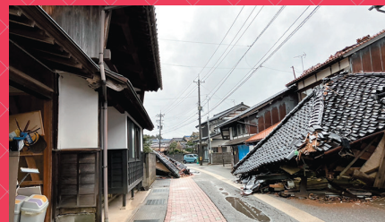
▲能登半島地震(石川県七尾市)の様子
