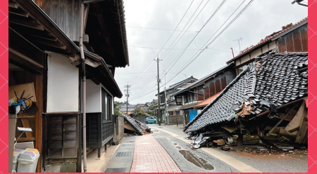
▲能登半島地震(石川県七尾市)の様子
