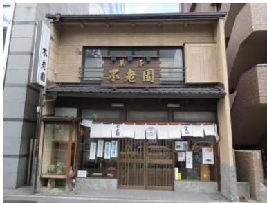
昭和30年築 店舗 中区古渡町11-32 H24.9.19
