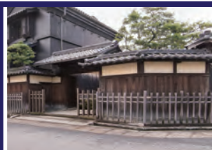
門 屋根：瓦葺 扉：板戸 堀 屋根：瓦葺 小壁：漆喰 腰壁：縦板張
