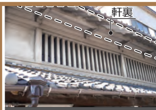
壁 面：漆喰塗籠 軒 裏：漆喰塗籠（波型） 開口部：虫籠窓（角柱・塗籠）
