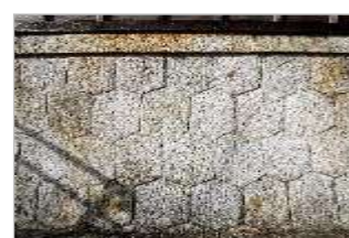
切石の石積(亀甲積)
