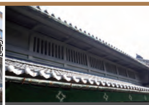
壁 面：漆喰塗籠 軒 裏：漆喰塗籠（平型） 開口部：虫籠窓（角柱・塗籠）
