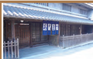
庇の下：土間（土庇） 開口部：木製建具・木格子
