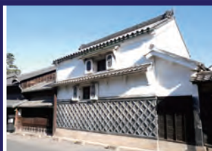
壁面：漆喰塗り・なまこ壁
