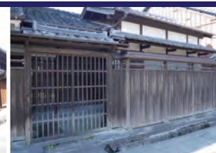
門 屋根：瓦葺 扉：木格子戸 堀 屋根：銅板葺 壁面：縦板張
