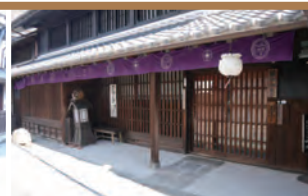
庇の下：一部土間（土庇） 開口部：木製建具・木格子
