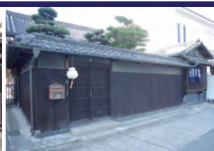
門 屋根：瓦葺 扉：木格子戸 堀 屋根：瓦葺 小壁：漆喰 腰壁：縦板張
