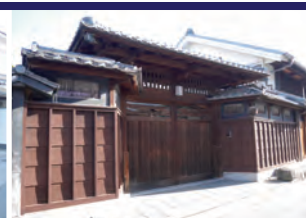
門 屋根：瓦葺 扉：板戸 堀 屋根：瓦葺 小壁：漆喰 腰壁：下見板張
