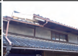
壁 面：真壁 軒 裏：木現 開口部：木製ガラス戸
