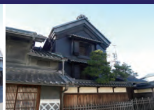
壁面：漆喰塗り・縦板張
