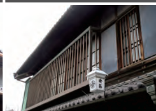
壁 面：真壁 軒 裏：木現 開口部：金属格子窓・銅製戸袋
