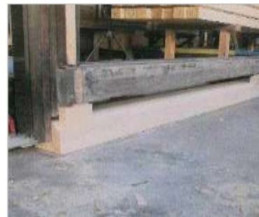
腐食した土台の交換
