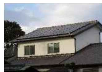
屋根と一体的に見える 太陽光パネル例
