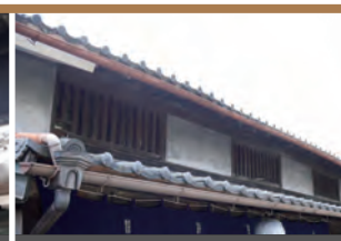
壁 面：漆喰塗籠 軒 裏：木現 開口部：虫籠窓（角柱・木現）
