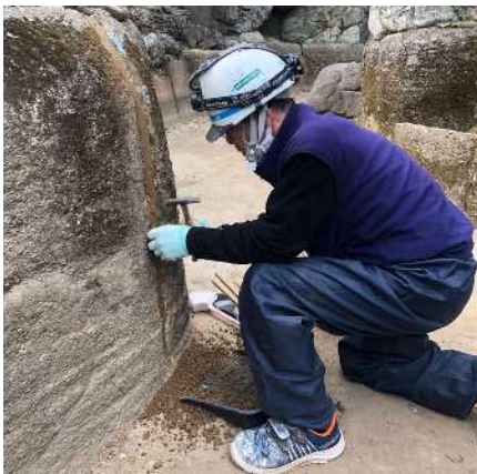
護岸ひび割れ修理
