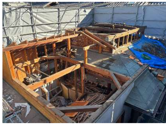
主屋南座敷増築棟取りこわしその他工事
