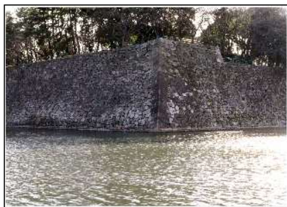
修復工事前の石垣(平成14年度)
