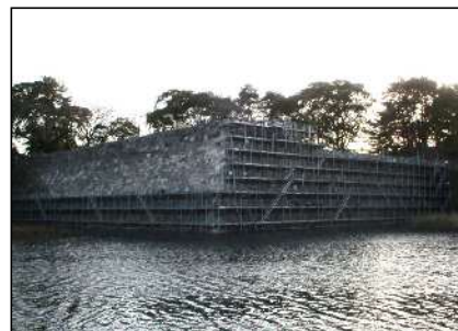
修復工事中の石垣(令和7年度末)
