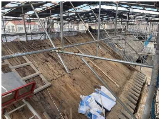
細工倉及び西倉解体保存工事
