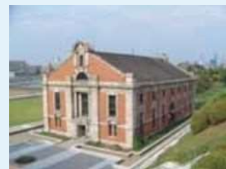
鍋屋上野浄水場旧第一ポンプ所
