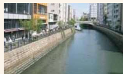
堀川と沿岸の店舗（納屋橋周辺）
