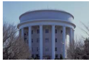
名古屋市演劇練習館アクテノン （旧稲葉地配水塔）
