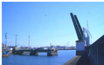
名古屋港跳上橋
