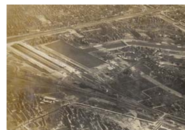
運河開削時の堀止船だまり
