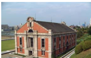
鍋屋上野浄水場旧第一ポンプ所
