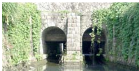
もとより 元杵樋門
