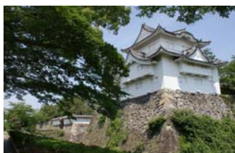
東南隅櫓（重要文化財）
