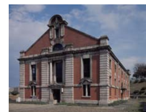
鍋屋上野浄水場 旧第一ポンプ所
