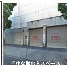
手狭な搬出入スペース
