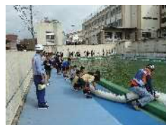
【ポンプ車による排水作業の見学】
