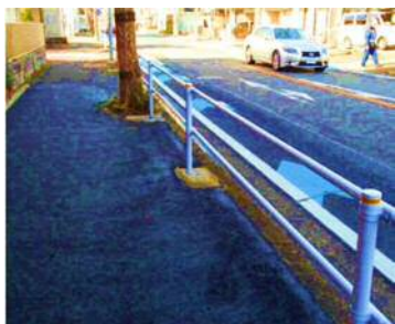
狭い歩道にガードパイプを設置
