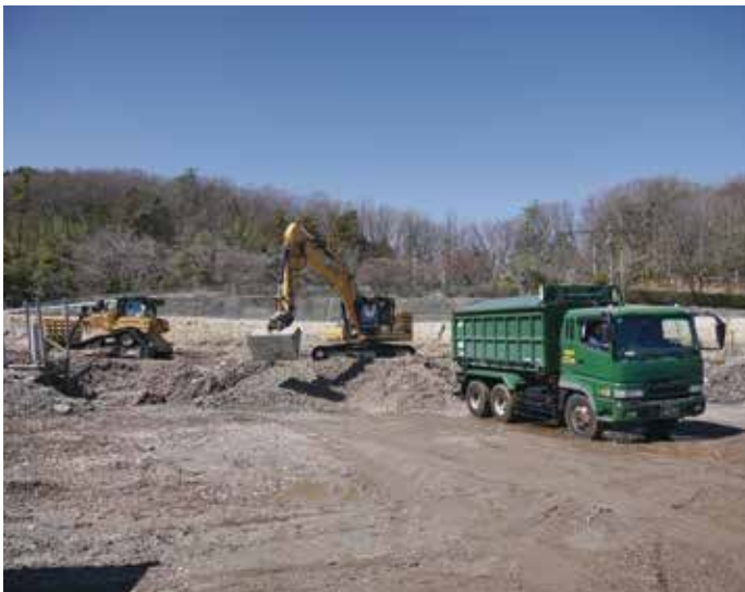
埋立方式 : サンドイッチ工法
