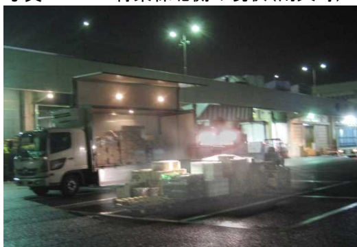
写真3-1 青果棟北側の現状(雨天時)
