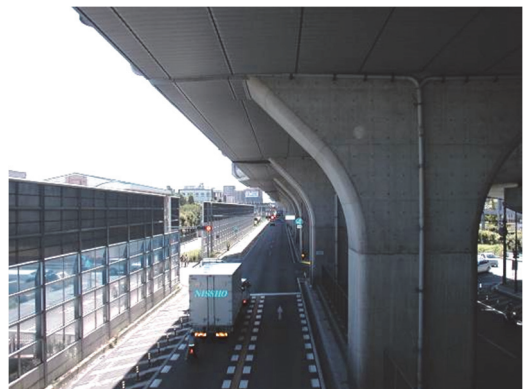
図 2 高層遮音壁の設置状況
