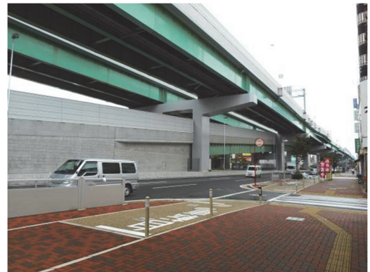
図 1 低層遮音壁の設置状況
