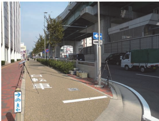
図3 低層遮音壁の測定地点状況
