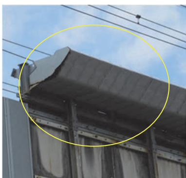
図 3 防音壁の設置状況 (干渉型防音壁 B)
