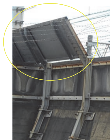
図 6 防音壁の設置状況 (直立防音壁斜めかさ上げ)
