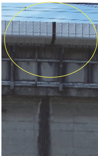
図 2 防音壁の設置状況 (干渉型防音壁 A)
