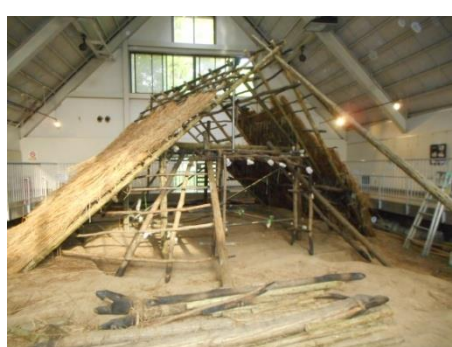
②骨組みが完成
