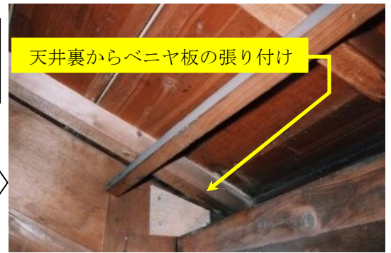
鴨居・長押部分の施工作業
