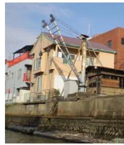
荷揚げ用クレーン
