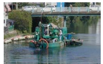
堀川環境整備事業(ヘドロ除去)
