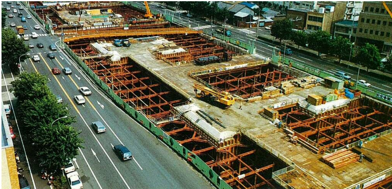
建設中の若宮大通調節池
