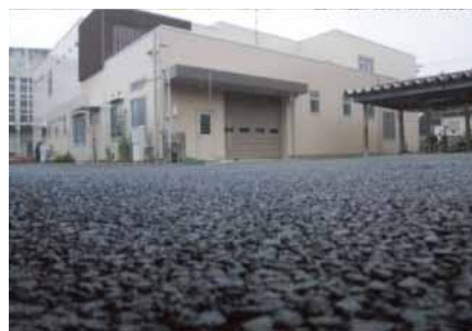
【写真14】透水性舗装の駐車場
