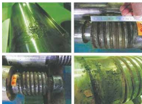
【写真10】ポンプ設備の老朽化
