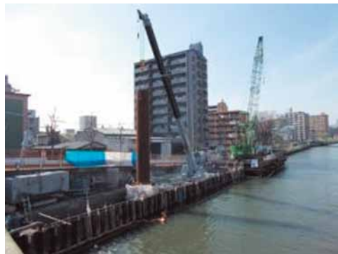
【写真8】堀川の護岸改修
