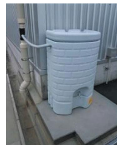
雨水タンクの設置
