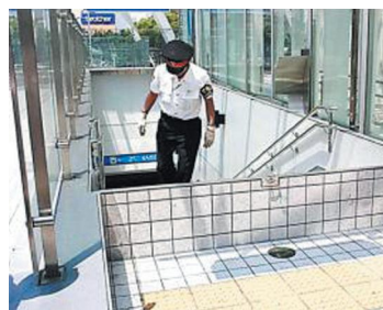
地下鉄の起上方式止水板
