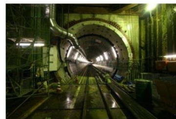
＜貯留施設の工事＞
