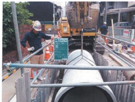
【写真11】下水管の改築にあわせた能力増強(増径)
