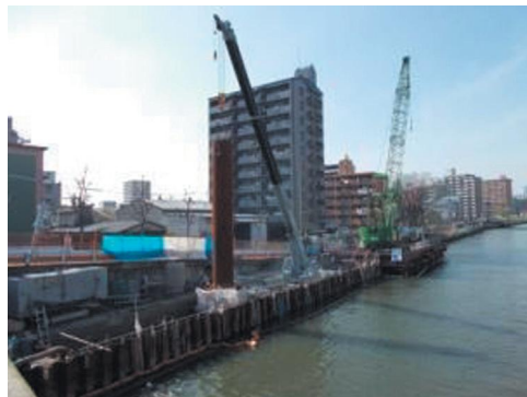
【写真8】堀川の護岸改修
