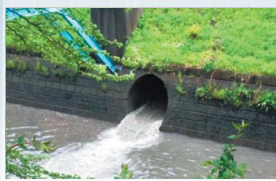
雨水の吐出し口
