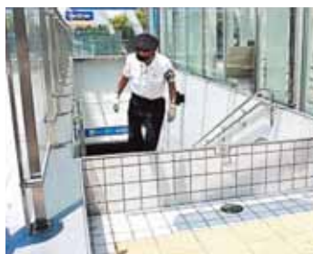
地下鉄の起上方式止水板
