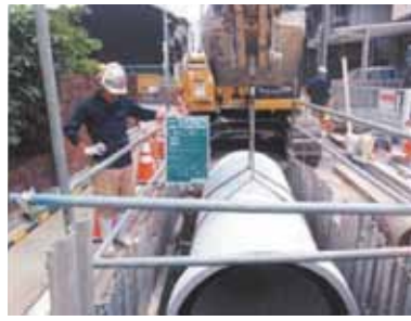
下水管の改築にあわせた能力増強
