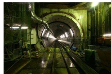
<貯留施設の工事>
