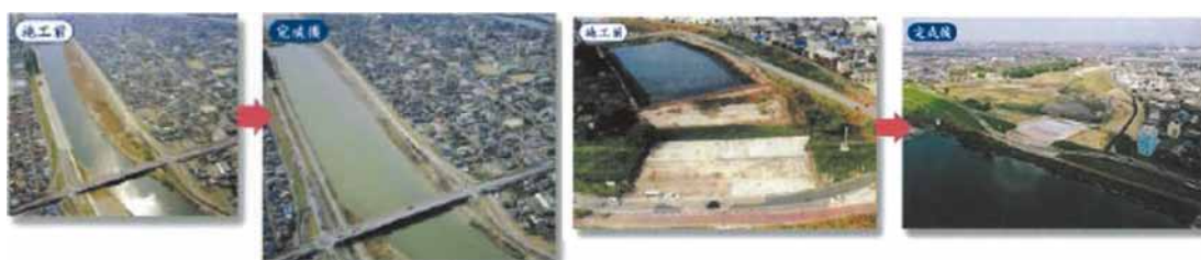
①庄内川 河床掘削(大当郎橋付近)
