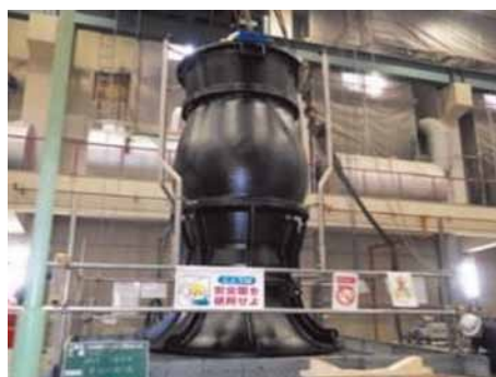
【写真12】ポンプ施設の改築にあわせた能力増強
