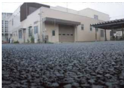
【写真14】透水性舗装の駐車場
