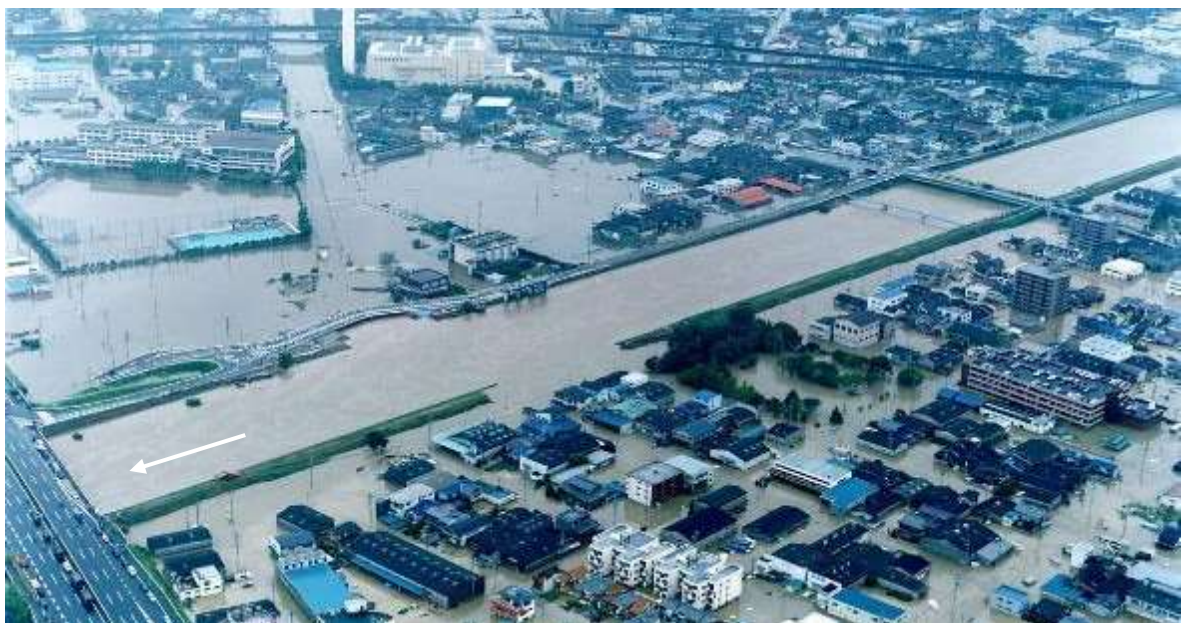
平成 12 年 9 月 12 日(東海豪雨) 新川新橋上流 新川破堤箇所
