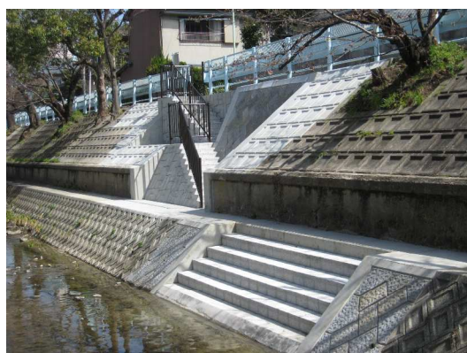
写真-4.6 親水施設の階段 (大島7号橋付近)
