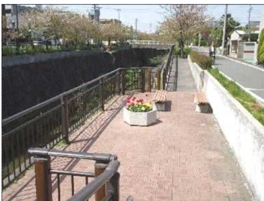
写真-4.3 景観に配慮した転落防止柵 かなえはし (鼎橋付近)
