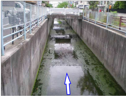
写真-1.1 上流部三面張区間 (河口から約12.0km)
