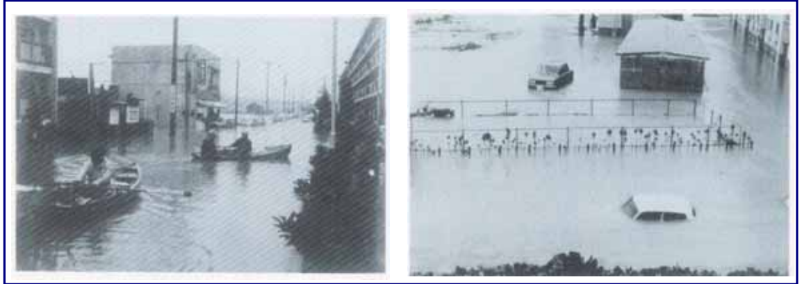
写真 - 13 被災状況（鳴海団地付近）
