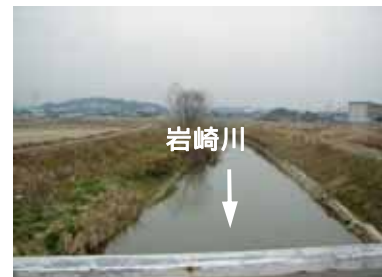
写真 - 12 岩崎川 (昭和橋 0.4km 付近)
