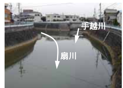
写真 - 5 扇川 （手越川合流点 4.5km 付近）
