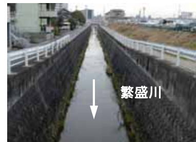
写真 - 11 繁盛川 (繁盛橋 0.4km 付近)
