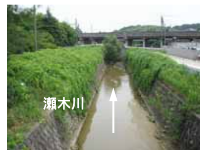
写真 - 8 瀬木川 (瀬木橋 0.1km 付近)
