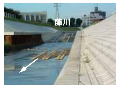
写真 - 9 藤川 (天白川合流部 0.1km 付近)
