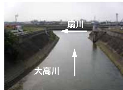
写真 - 7 大高川 (扇川合流部 0.0km 付近)
