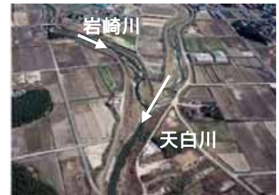
写真 - 2 天白川 （岩崎川合流点 16.8km 付近）
