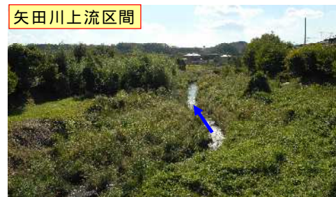
屋戸橋(22.3k)より下流を望む
