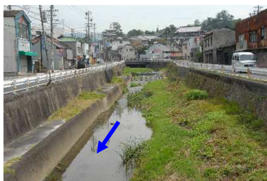
瀬戸川 東橋上流5.5k付近
