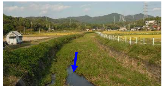
大谷川 神多橋上流2.3k付近
