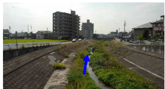
地藏川 やまぎわ橋下流11.2k付近
