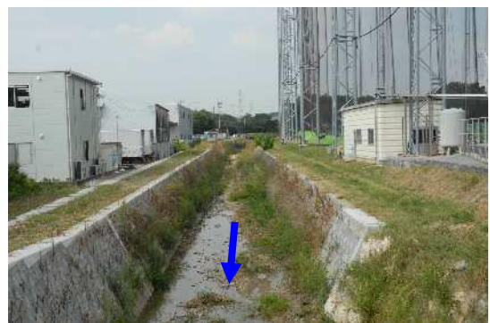
生地川 東山橋上流2.0k付近
