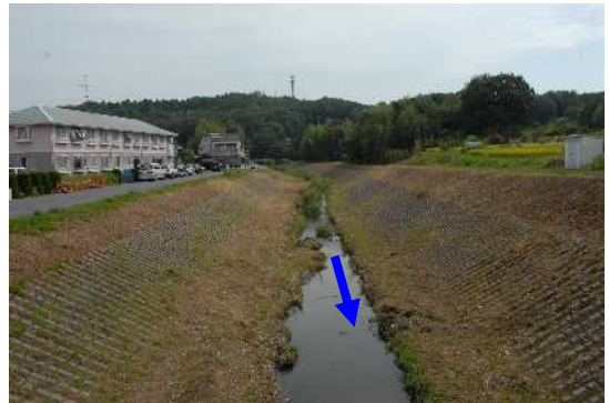
香流川 南島橋上流7.9k付近
