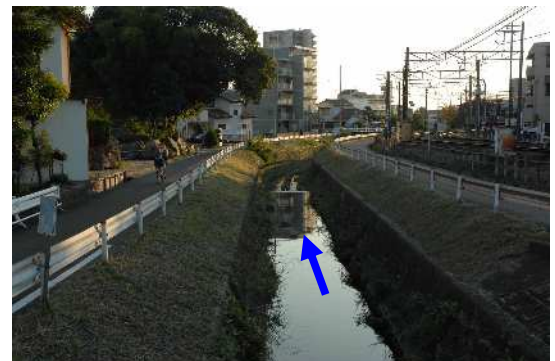
隅除川 喜多呂橋下流1.5k付近
