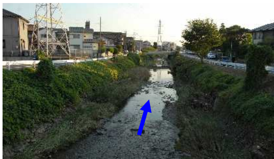
天神川 郷土橋下流0.2k付近
