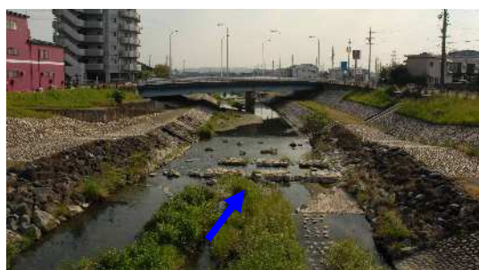
内津川放水路 1.7k付近
