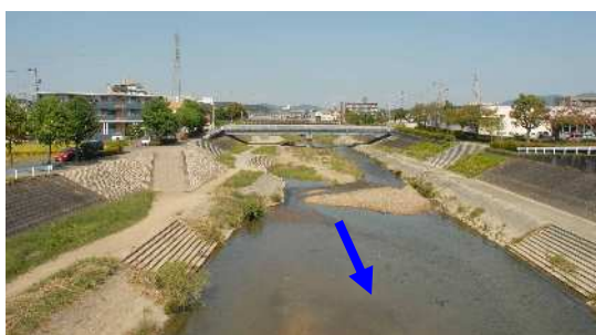
内津川放水路 0.7k付近
