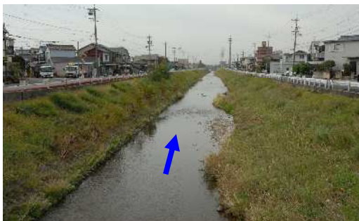
八田川 稲口橋下流 3.4k 付近
