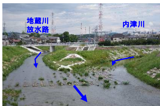
内津川 地蔵川放水路合流点1.3k付近
