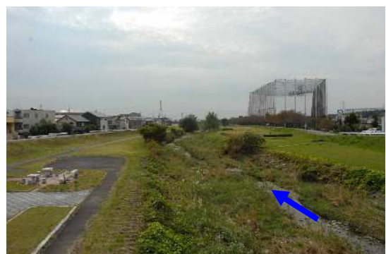
内津川 出川橋下流4.0k付近
