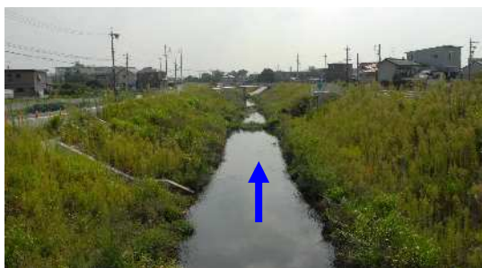
地藏川放水路 関田東橋下流10.1k付近
