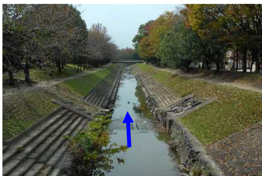
生地川 池合橋下流0.6k付近
