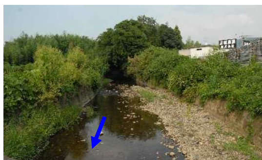
内津川 上田橋上流10.8k付近
