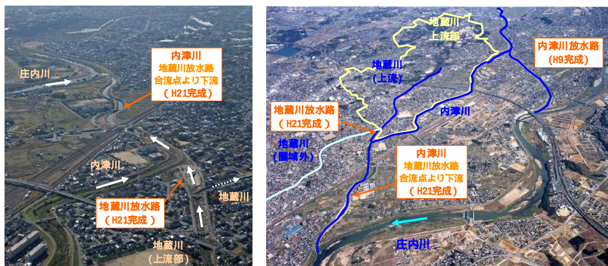
写真 - 1.1.2 地藏川放水路
