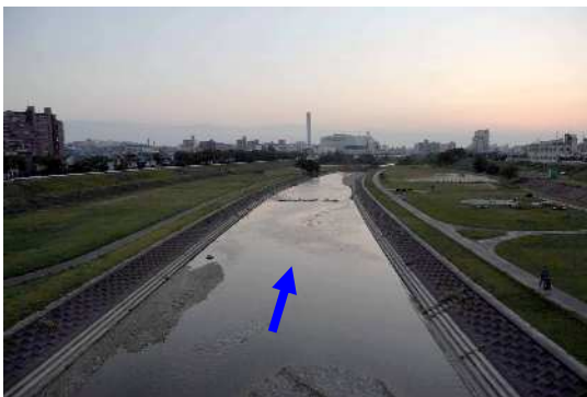
矢田川 小原橋下流9.8k付近
