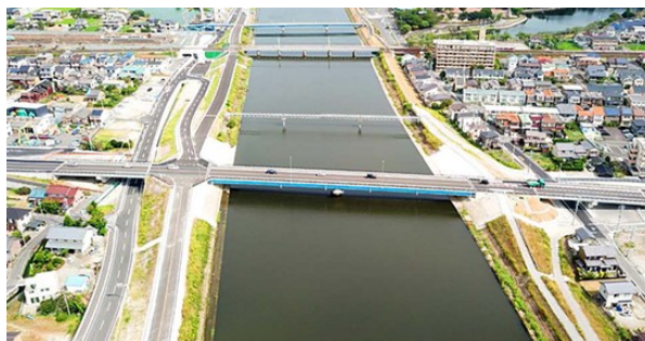
写真－22 日光川 国道一号日光大橋
