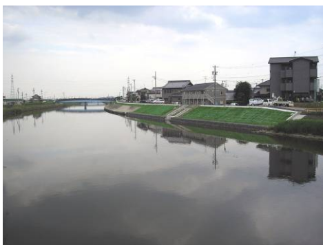
写真－21 近年の日光川本川の築堤・護岸工事
