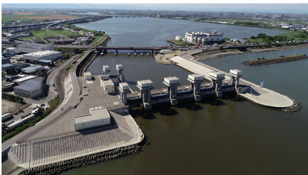
写真－23 水閘門及び河口排水機場
