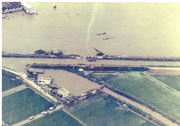
写真－17 被災状況
