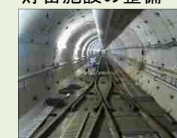
貯留施設の整備
