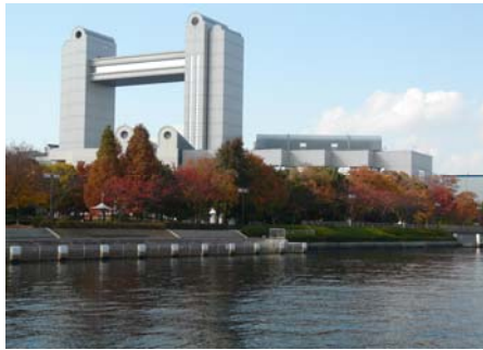
写真-2.3 整備拠点（白鳥地区）
