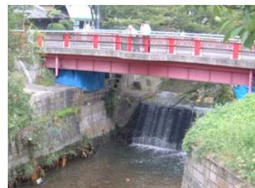
写真-1.9 猿投橋と落差工
