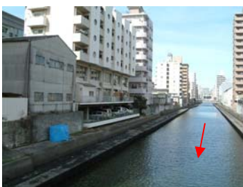
写真-1.14 富士見橋(4.85k)下流
