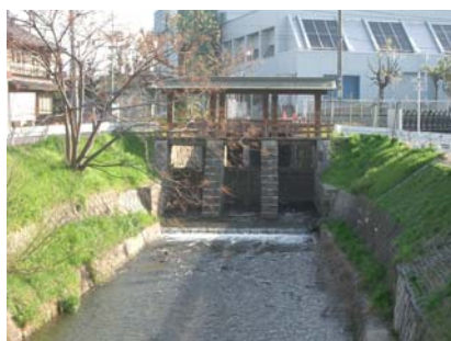
写真-1.1 黒川樋門
