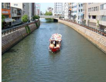
写真-1.17 納屋橋地区
