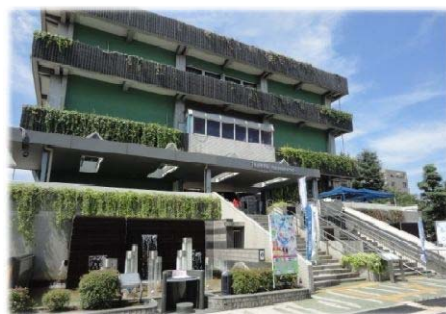
名城水処理センター
