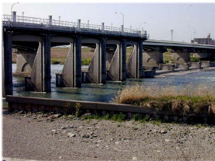
庄内用水頭首工
