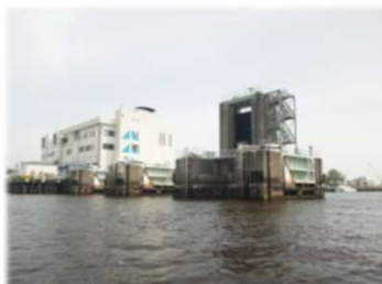
堀川口防潮水門
