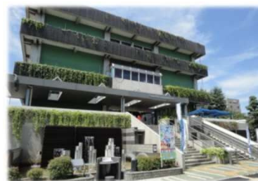
名城水処理センター
