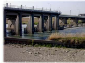
庄内用水頭首工
